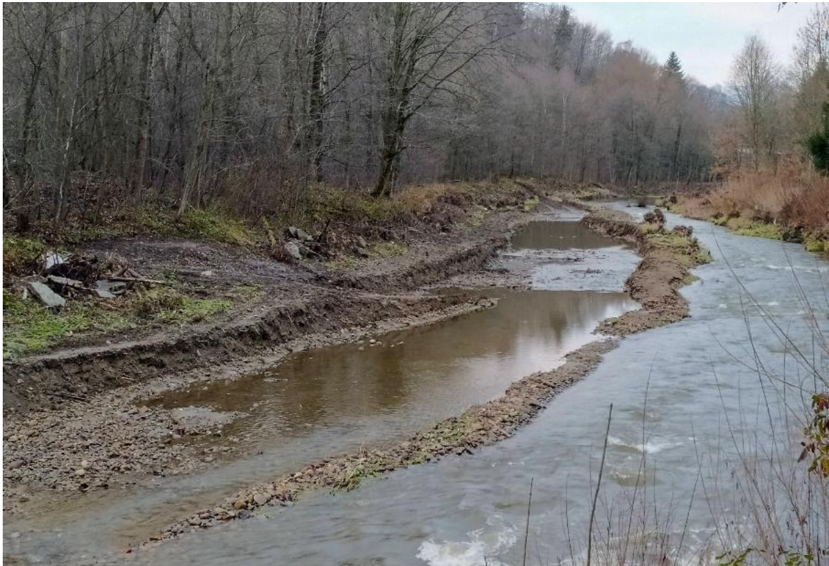
Obrázek 3. Říční lavice č. 9, realizace dlouhodobě plánované údržby štěrkové lavice dle schválené metodiky.
