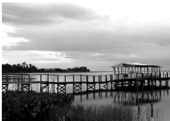
Zašlá sláva Apopky: zchátralá stavba jedné z kdysi prosperujících půjčoven loděk (vyhlášená rybí restaurace na břehu již byla stržena).
